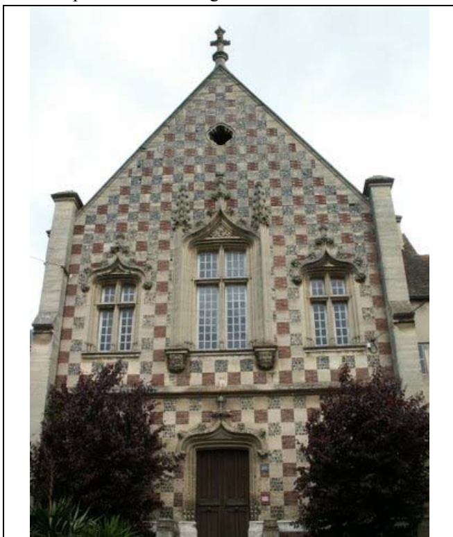
L'ancien tribunal (façade de la prison de Verneuil sur Avre)
